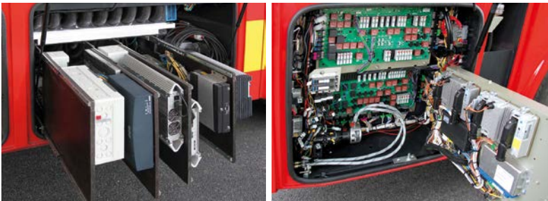
Einbau und Anschluss der Steuerungskomponenten
